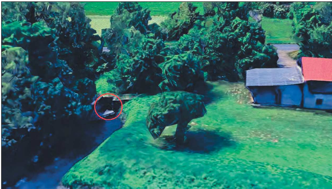
Figura 21. Vista frontale dello scarico del canale by-pass nel fiume Olona. In rosso è riportata la posizione dello scarico.
